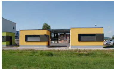
Südansicht der beiden Messkuben auf dem Gelände der Bauakademie Salzburg. (Bild: Schlotterer)
